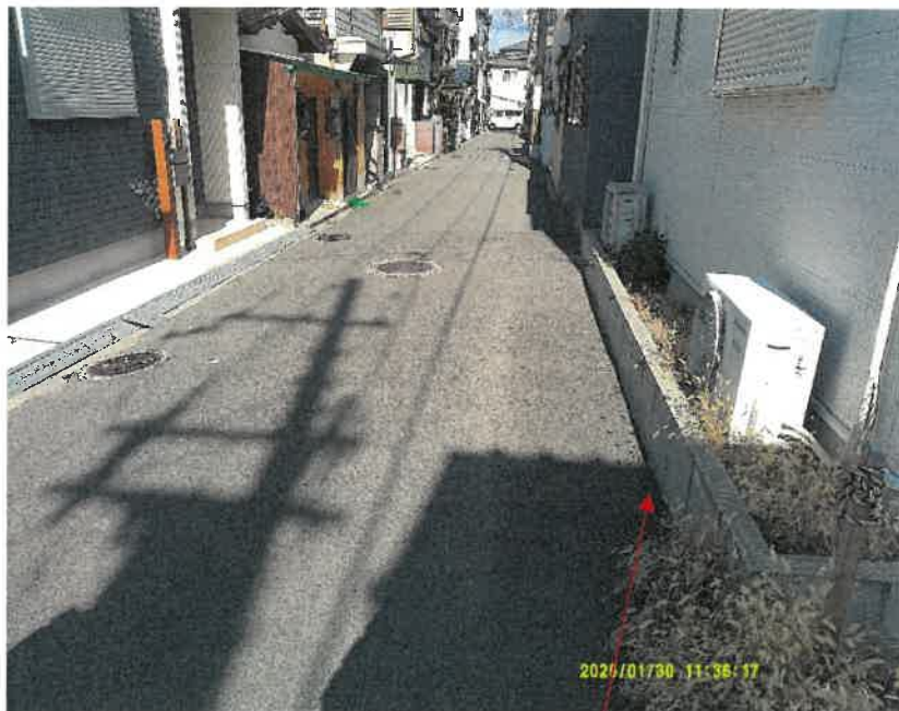
物件1 道路負担部分
