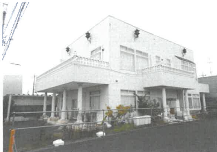
① 建物の外観
