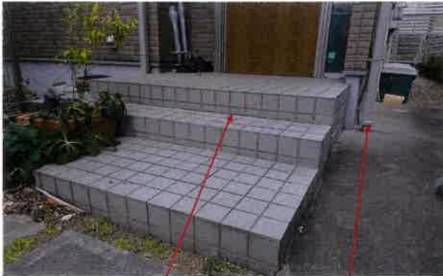
階段の亀裂
