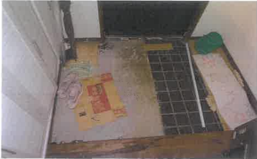
1階北東側玄関タイル
