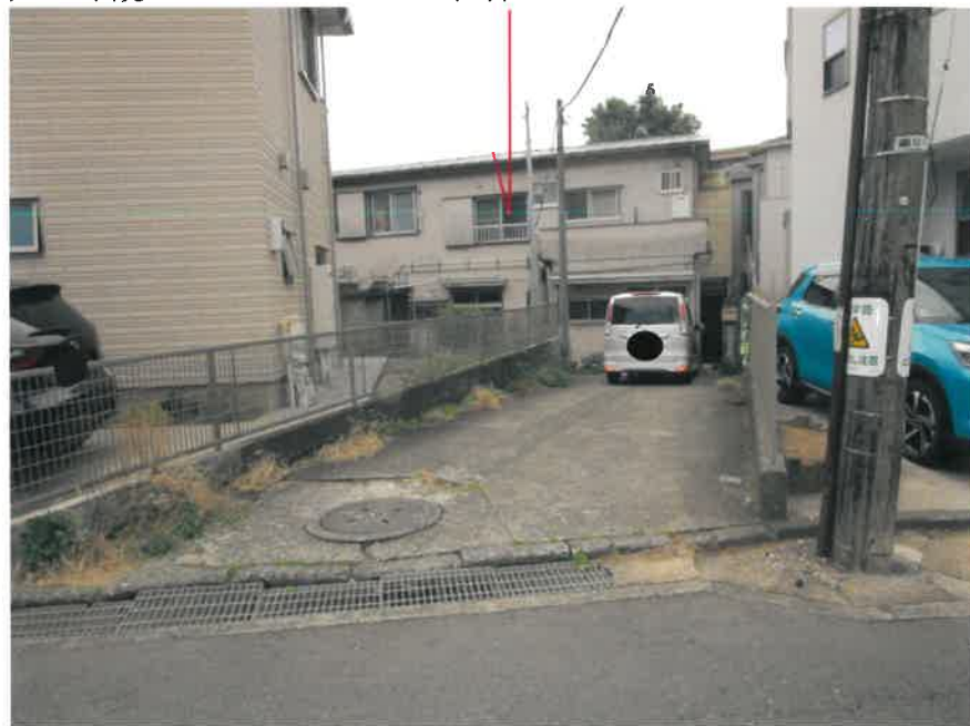
② 建物の外観 物件6
