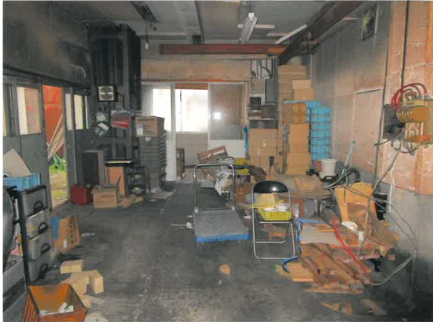
⑦ 建物内の状況 物件5の1階
