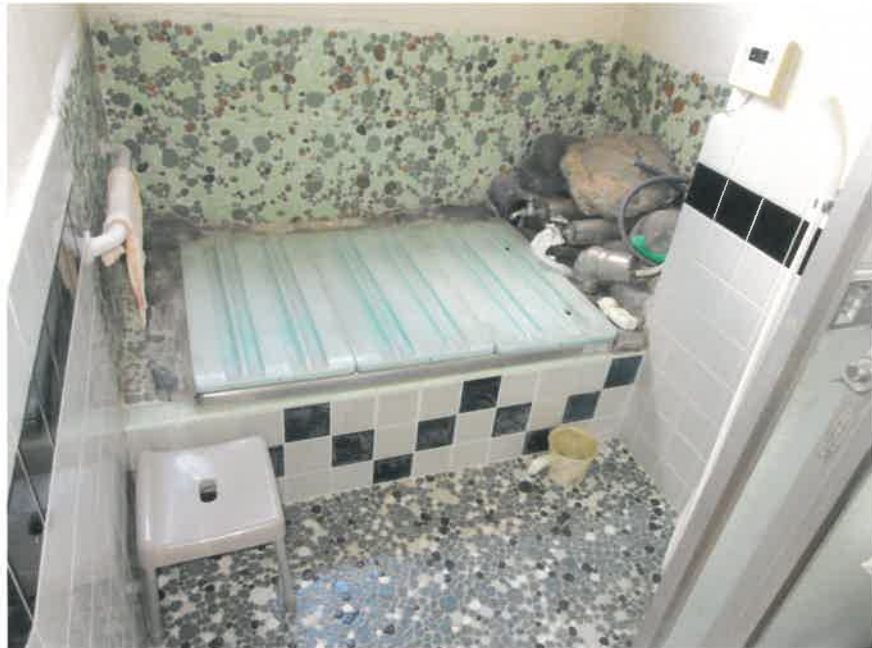
⑧ 建物内の状況 物件5の2階
