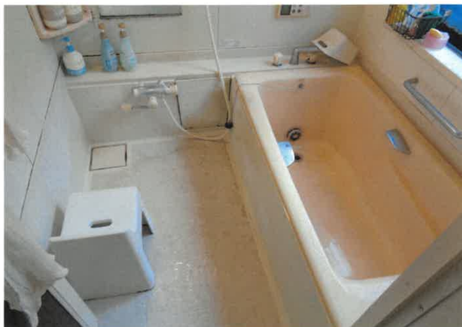
屋内の状況 浴室1
