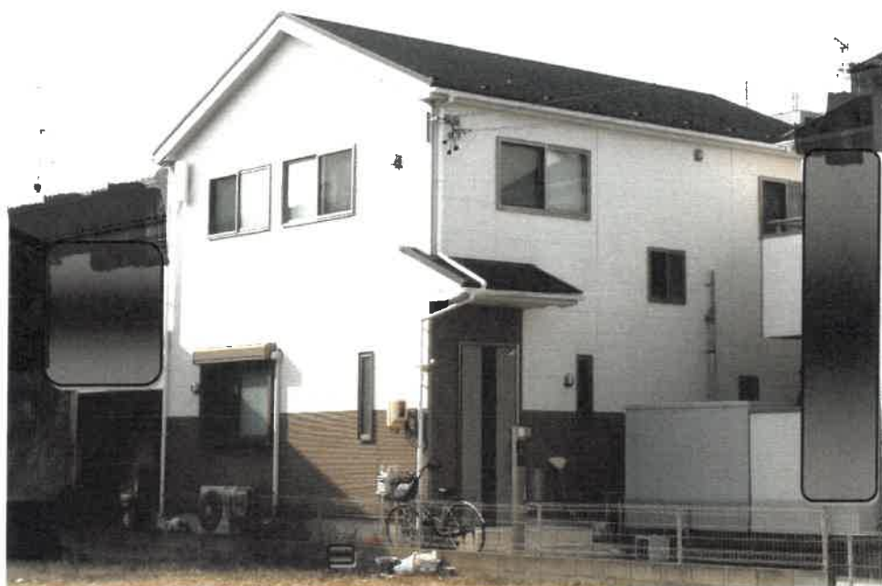
① 物件1土地を含む物件2建物の外観
