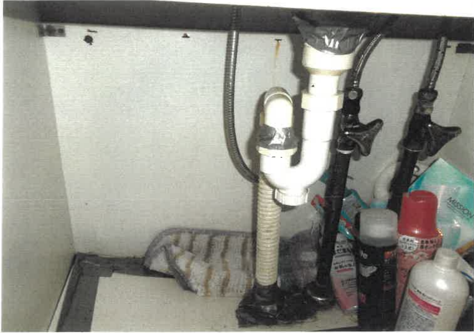
⑦ 洗面台下のパイプの状況
