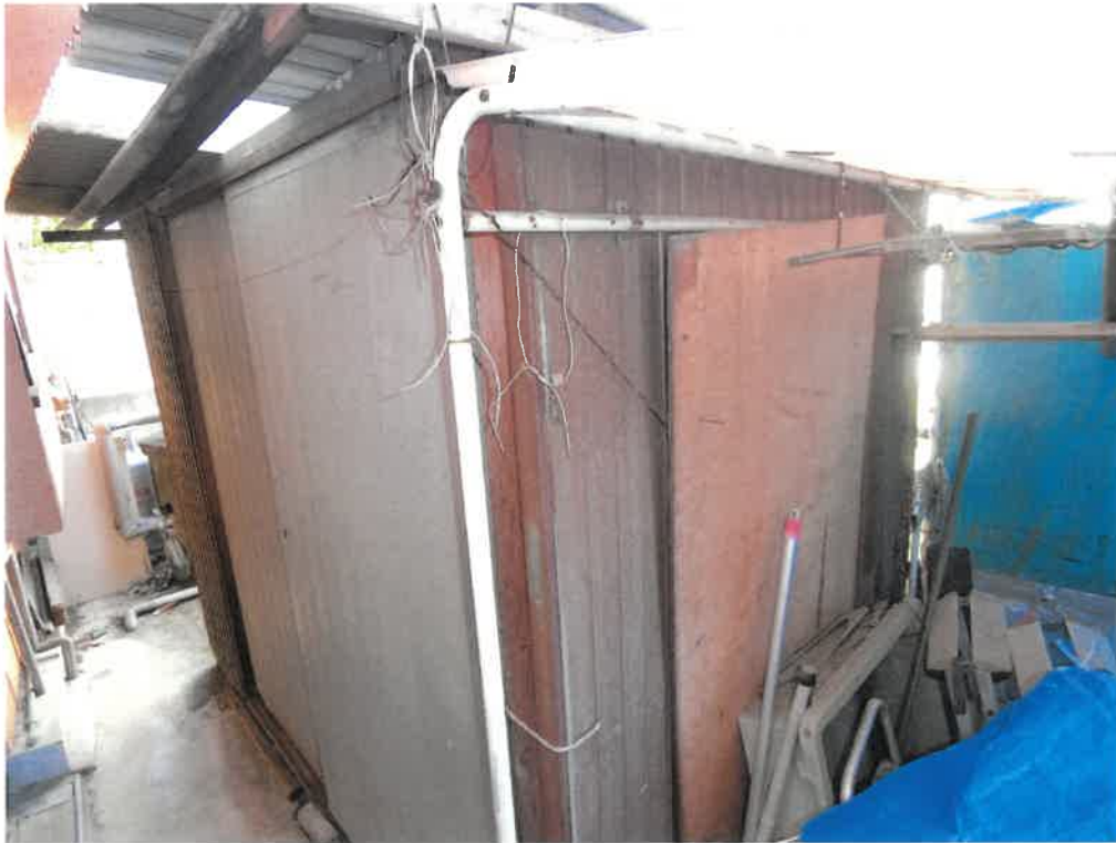
10 物件1 土地に設置された簡易物置
