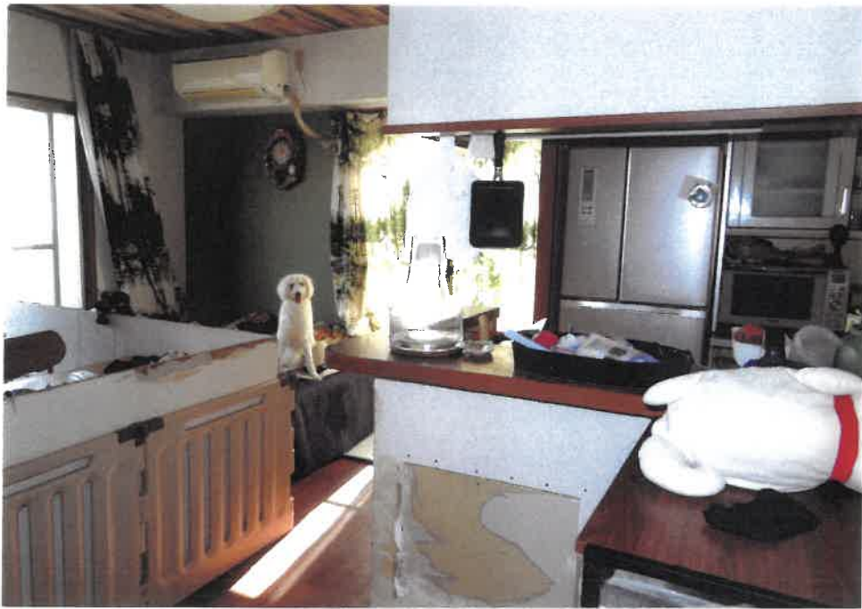
⑤ 屋内の状況（リビングダイニングキッチン）
