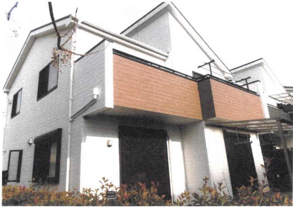
① 物件1土地を含む物件2建物の外観
