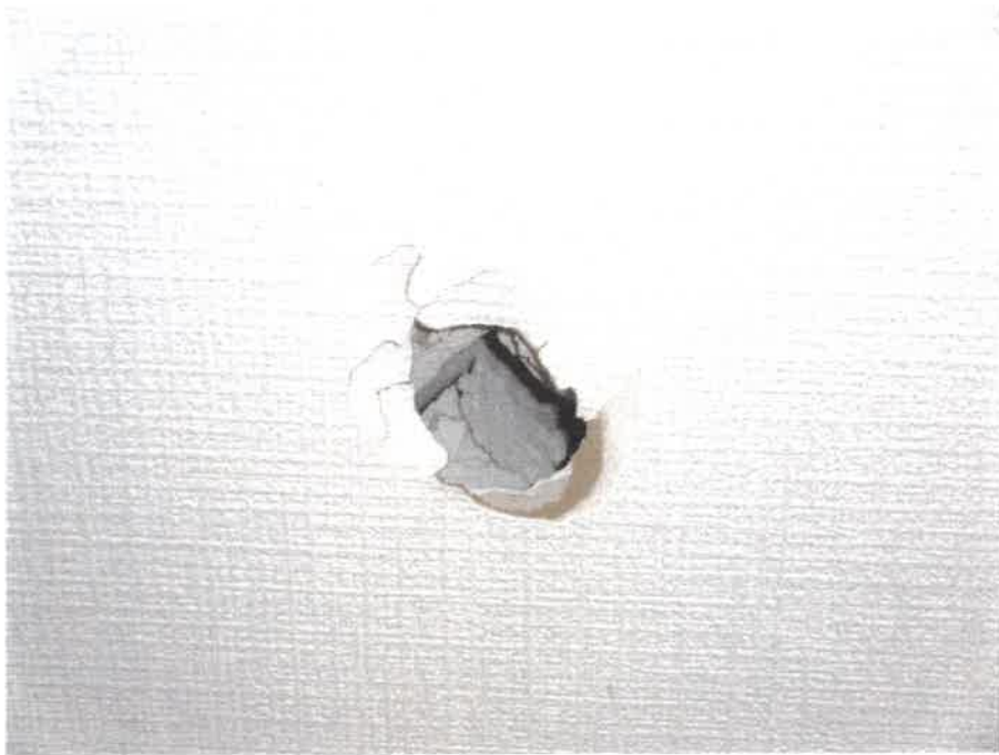
⑧ 洋室3のクロスの状況
