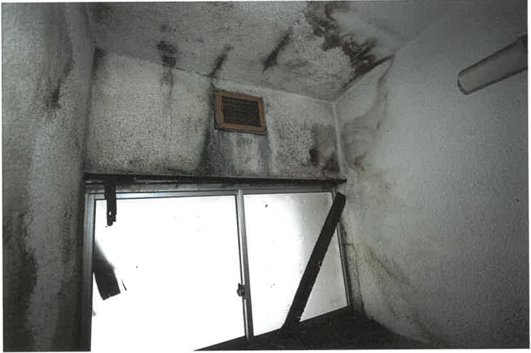
物件 2 建物室内
