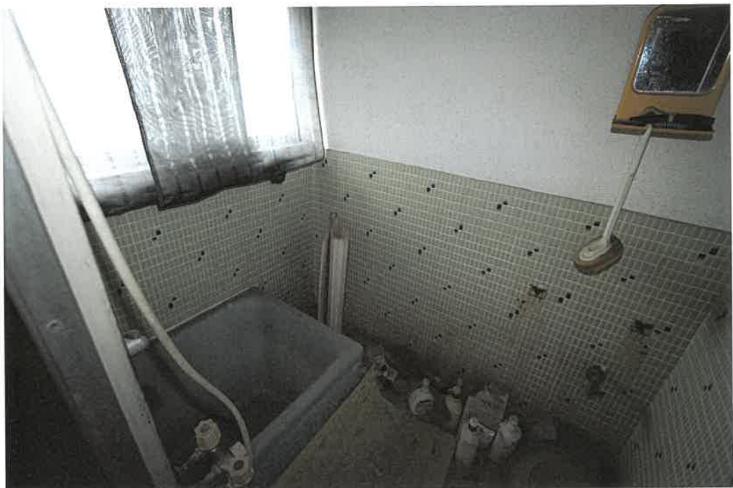
物件 2 建物室内
