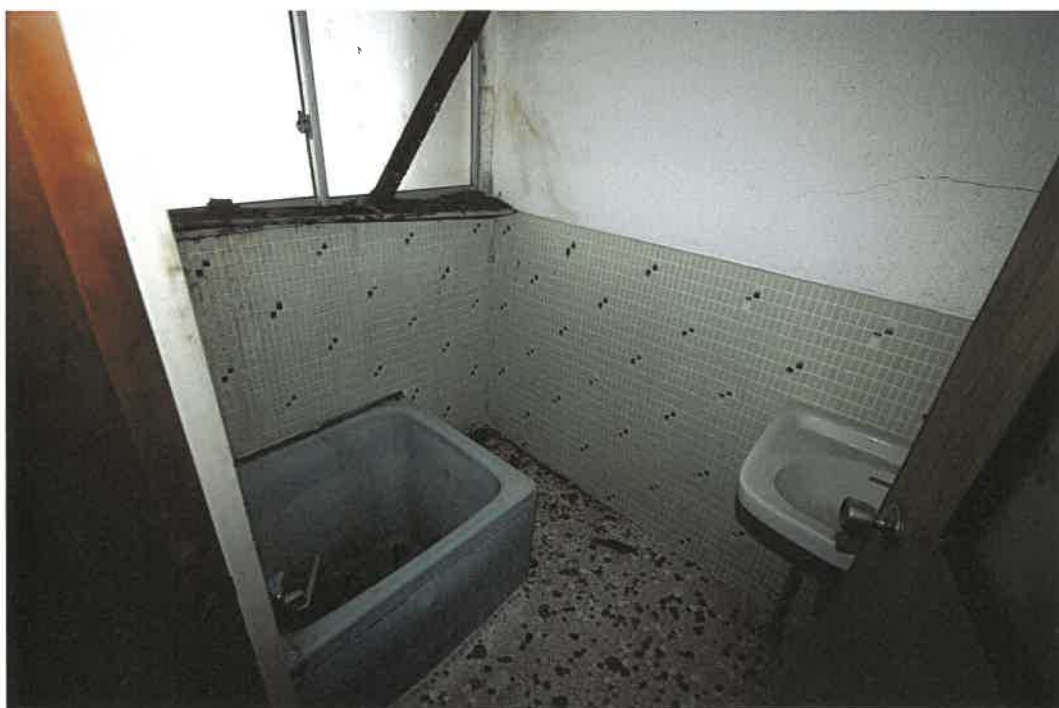
物件2 建物室内
