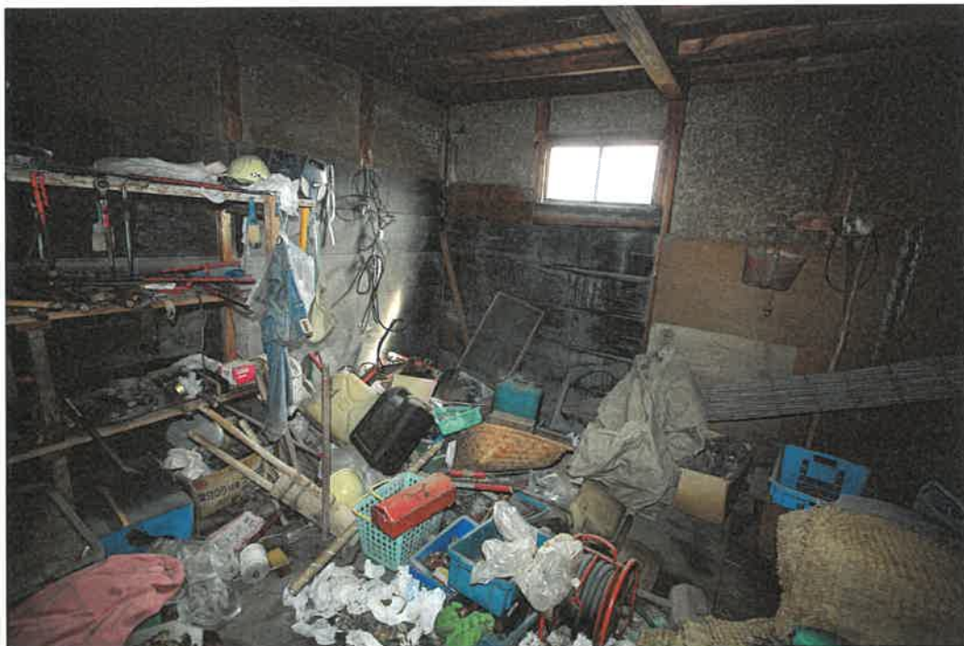
物件 5 附属建物 3 1 階室内
