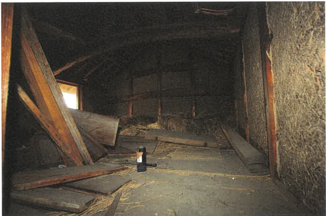
物件 5 附属建物 3 2 階室内
