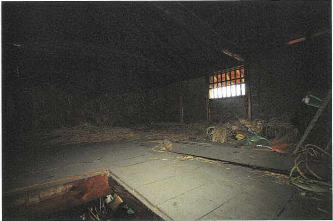
物件 5 附属建物 3 2 階室内
