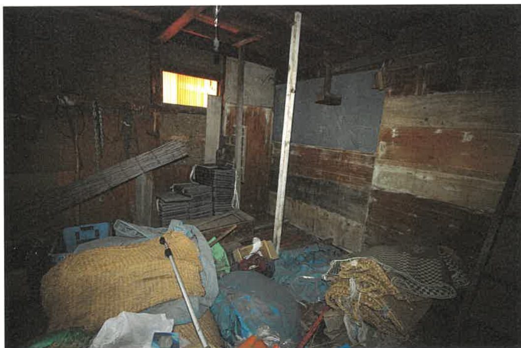
物件 5 附属建物 3 1 階室内
