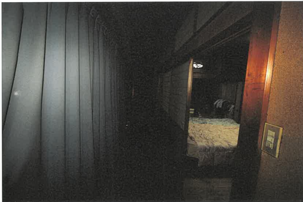
物件 5 附属建物 1 室内
