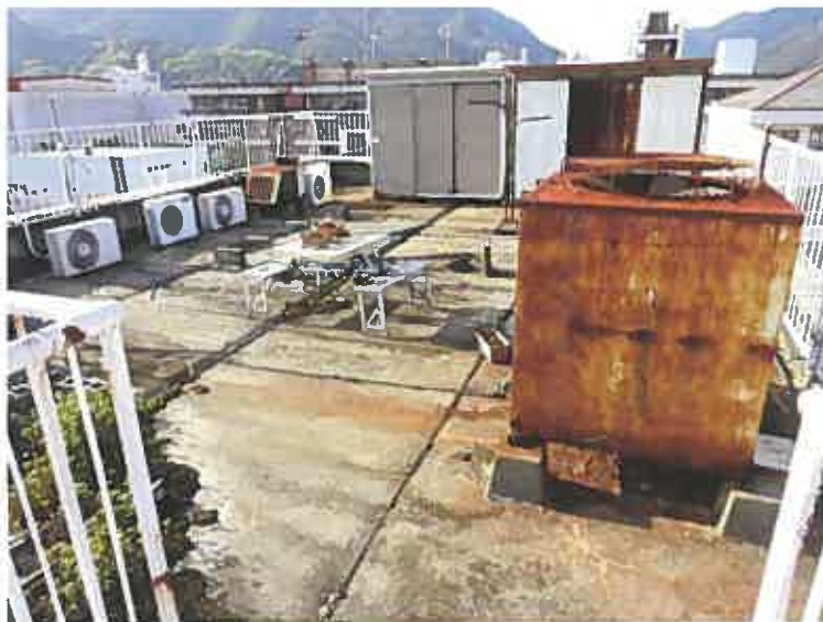
写真26 (本件建物 屋上 (南東端付近から北西側方向を撮影))
