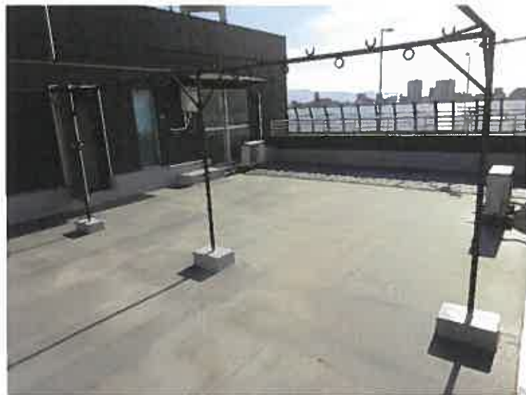
写真47 (本件建物 屋上)
