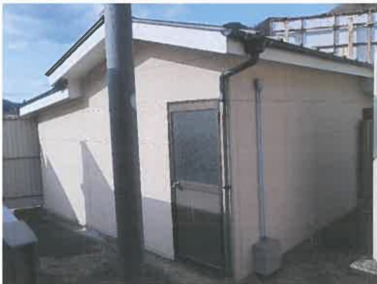
写真81 物件5建物附属建物符号11 (機械室)
