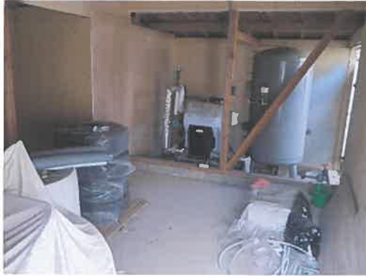
写真82 物件5建物附属建物符号11 (機械室)
