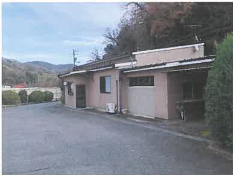
写真3 物件5建物（主たる建物・事務所）
