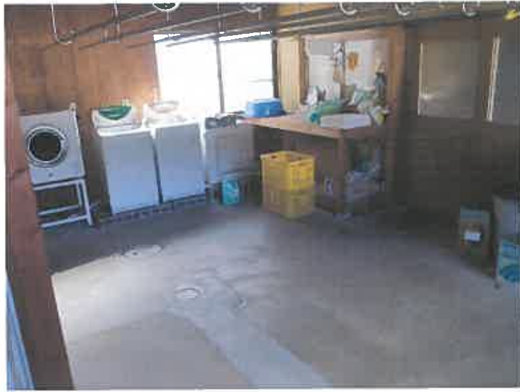
写真16 物件5建物（主たる建物・事務所）
