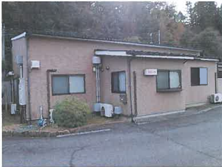
写真2 物件5建物（主たる建物・事務所）
