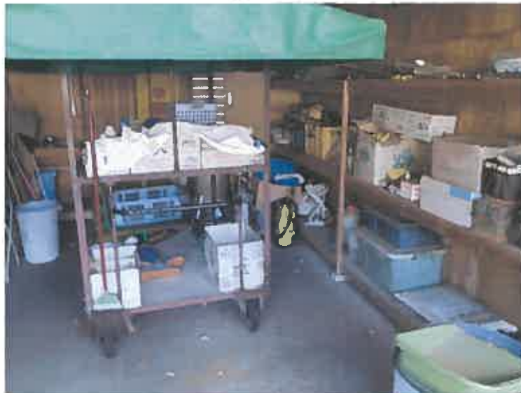
写真19 物件5建物（主たる建物・事務所）
