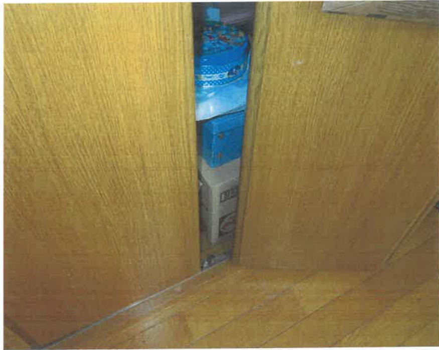
レールから外れて閉まりにくいクローゼット(CL)の扉
