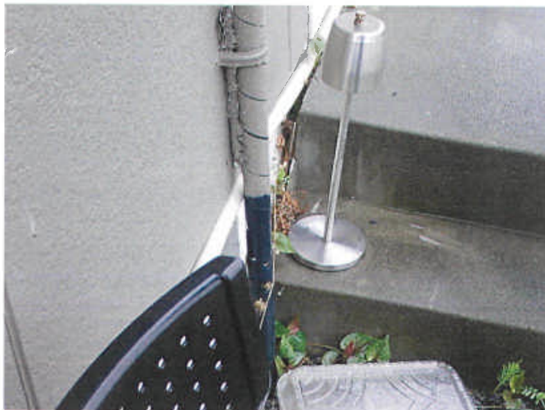
勝手口のコンクリートたたきと建物基礎の隙間 ⑥
