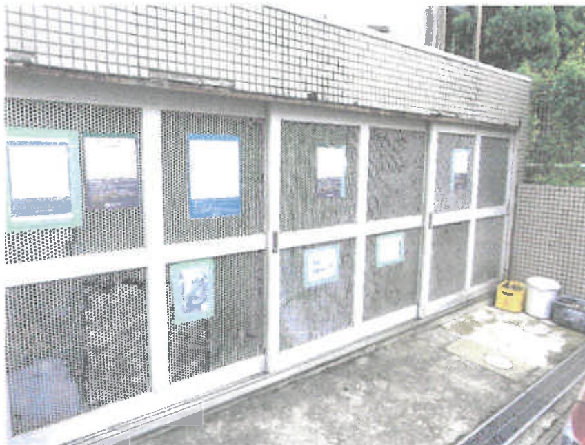
3 附属建物（符号1：塵芥室）
