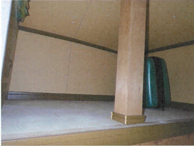
物件2の土地を含む公衆用道路接面部分 ⑧
