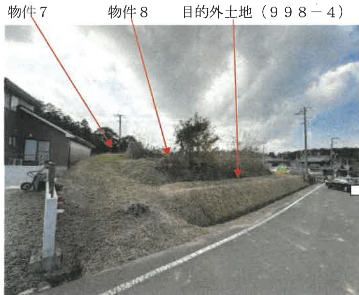
物件8北東側の状況
