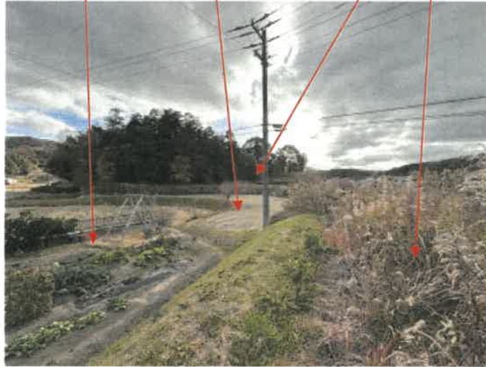
物件7 北東側の状況
