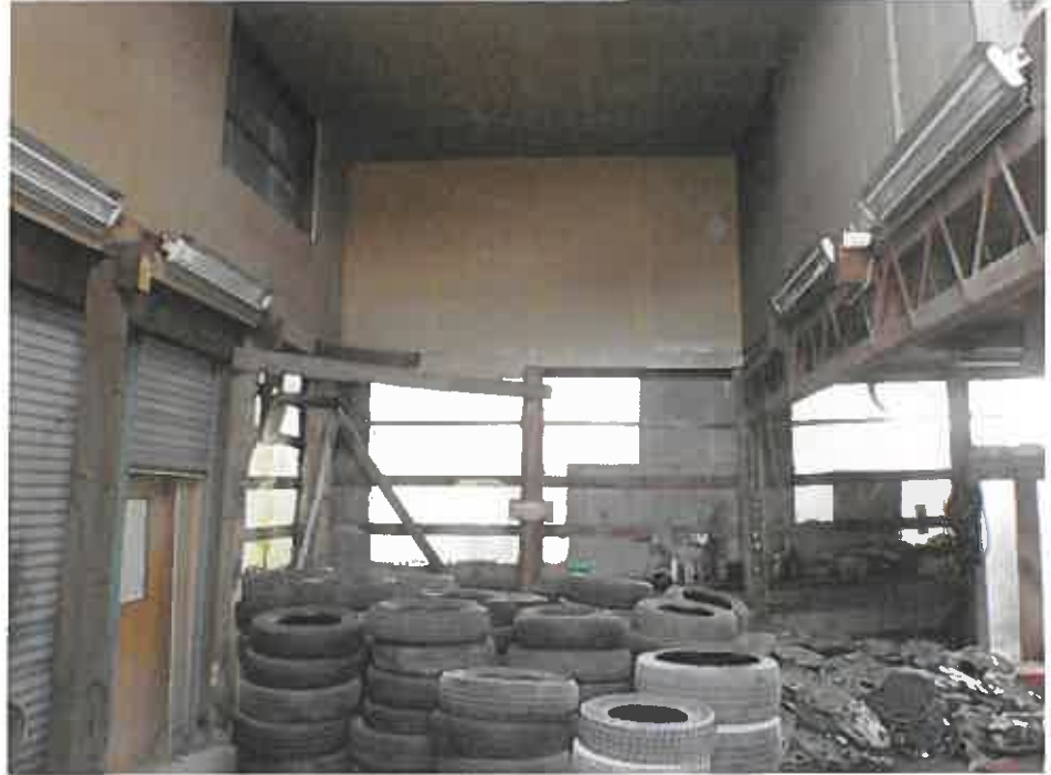
物件2 1階作業場
