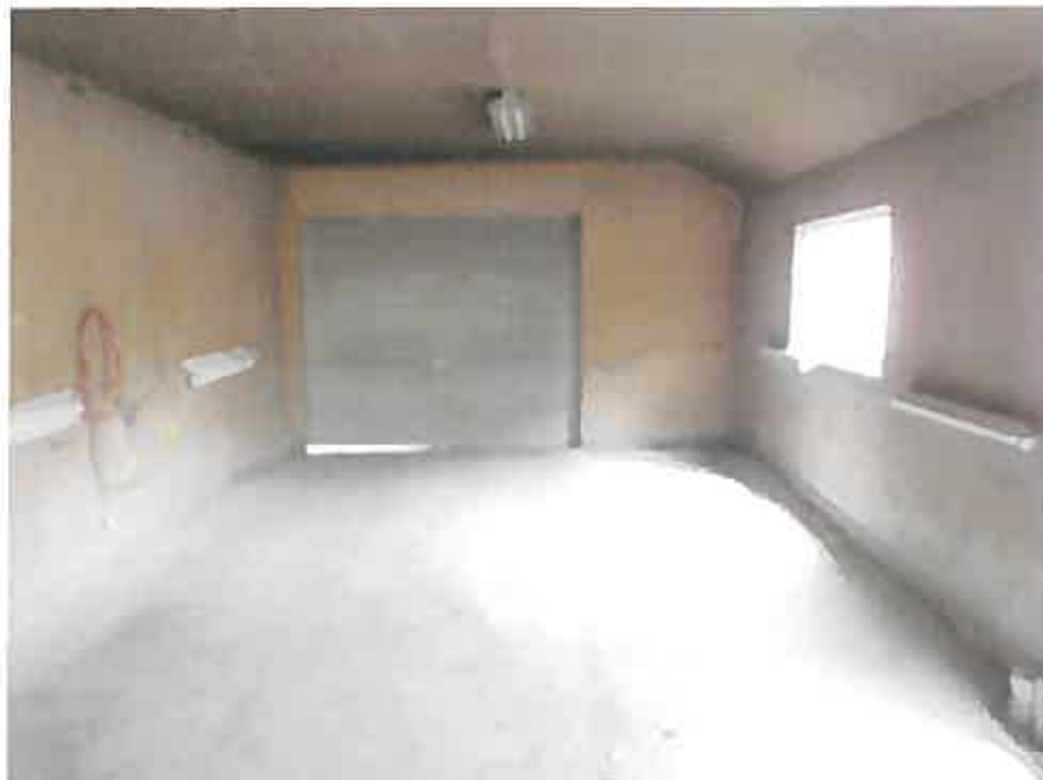
物件2 1階作業場
