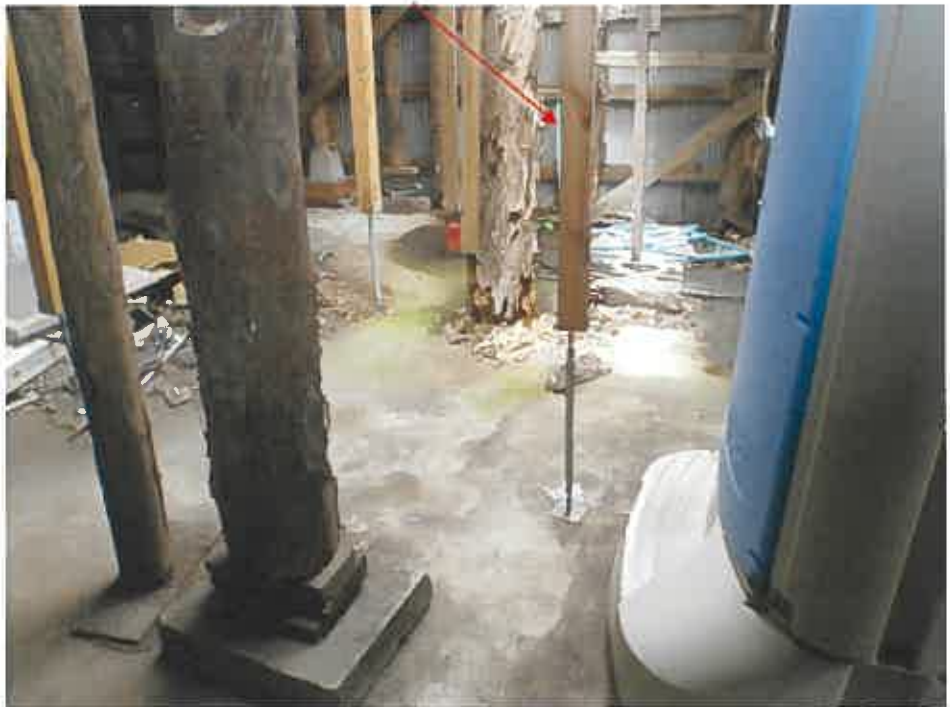
物件2 1階作業場（応急的に補強している状況）
