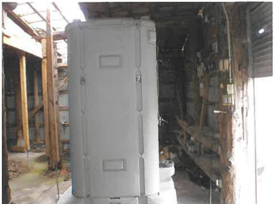
物件2 1階作業場
