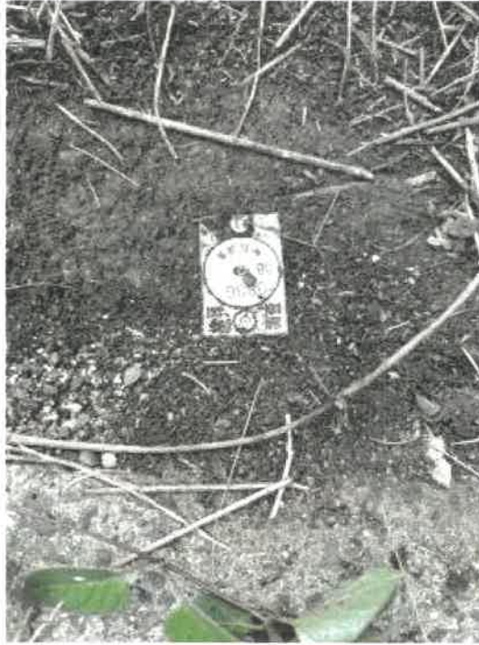
物件2北西側の境界標の状況
