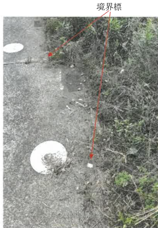
物件 2 南東側付近の状況
