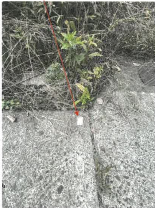
物件 2 南東側境界付近の状況
