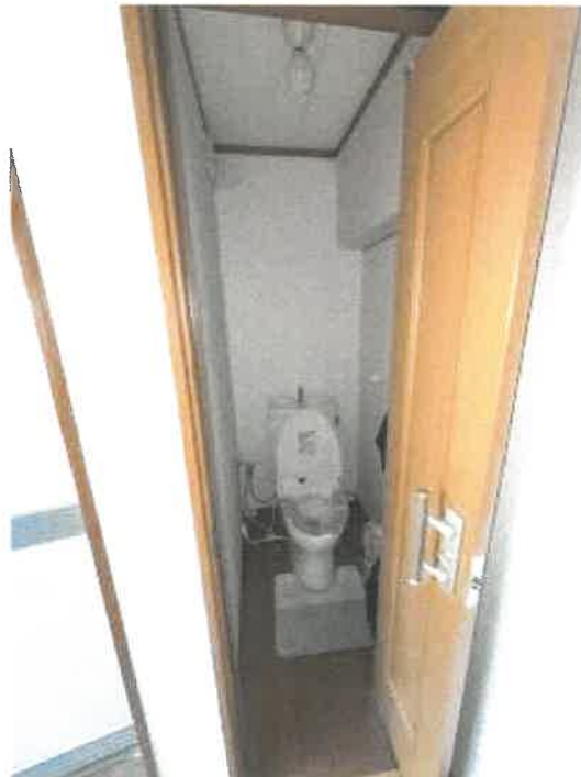
物件2 302号室トイレの状況
