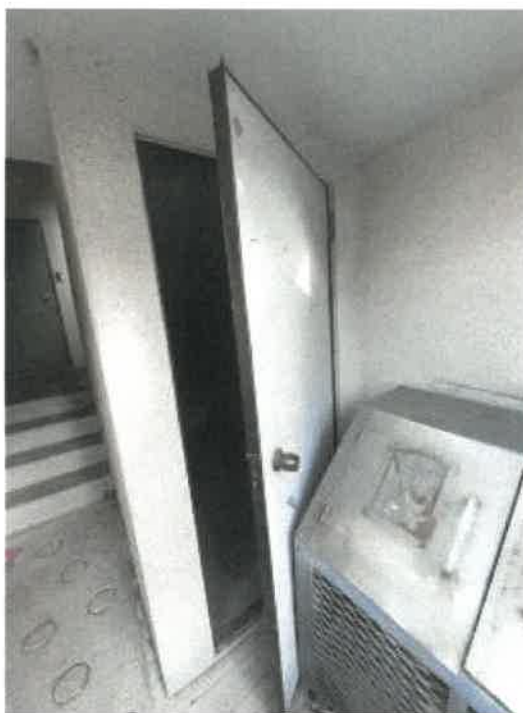
物件2 1階倉庫（階段下）の状況
