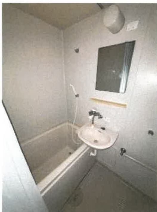
物件2 202号室ユニットバスの状況
