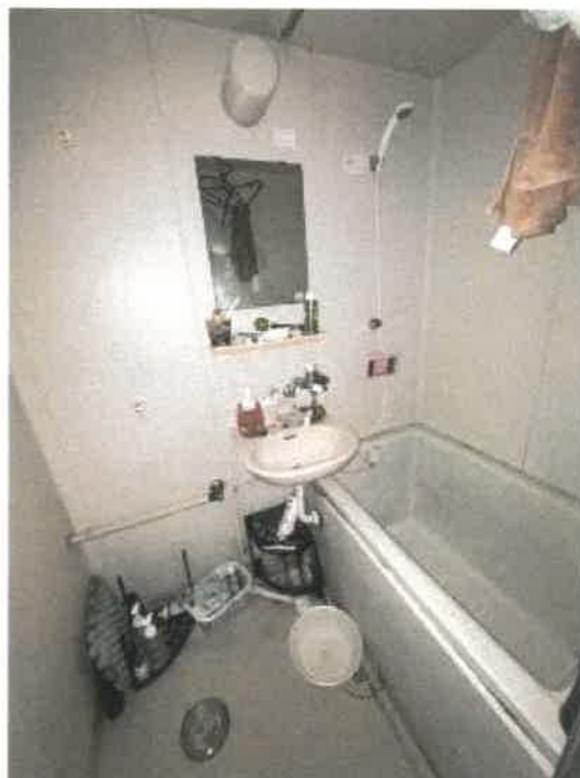
物件2 201号室ユニットバスの状況
