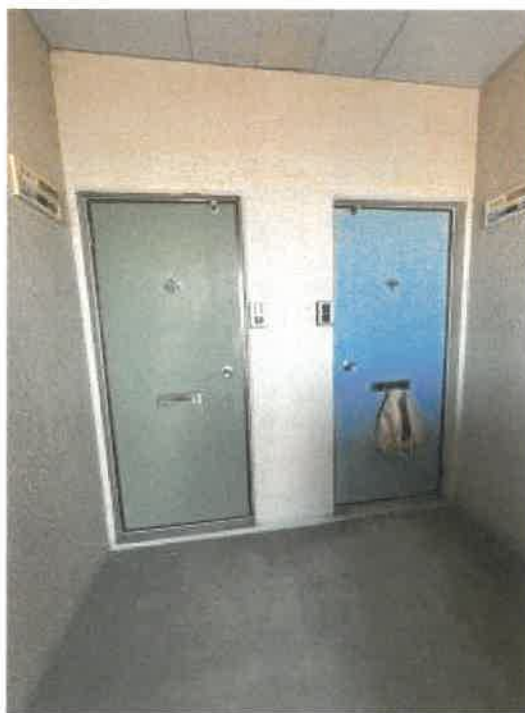
物件2 3階玄関ドアの状況
