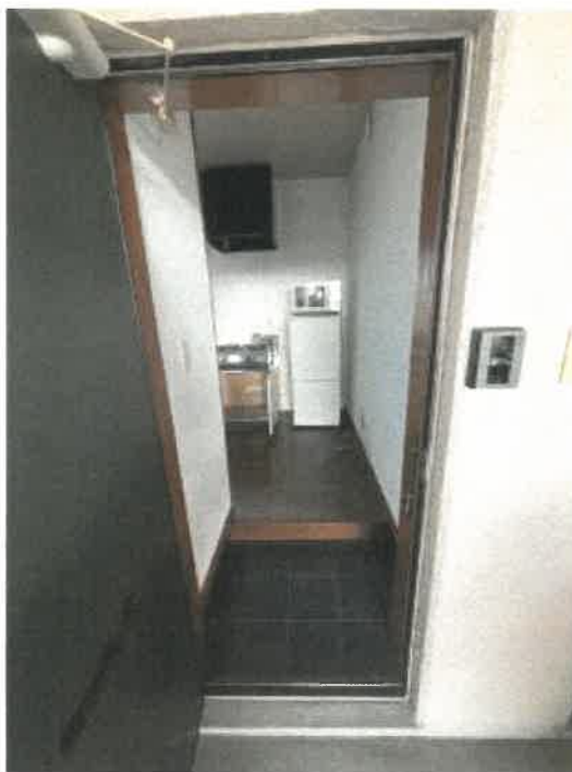
物件2 301号室玄関内の状況
