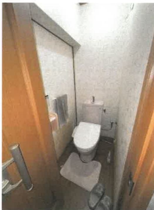
物件2 201号室トイレの状況
