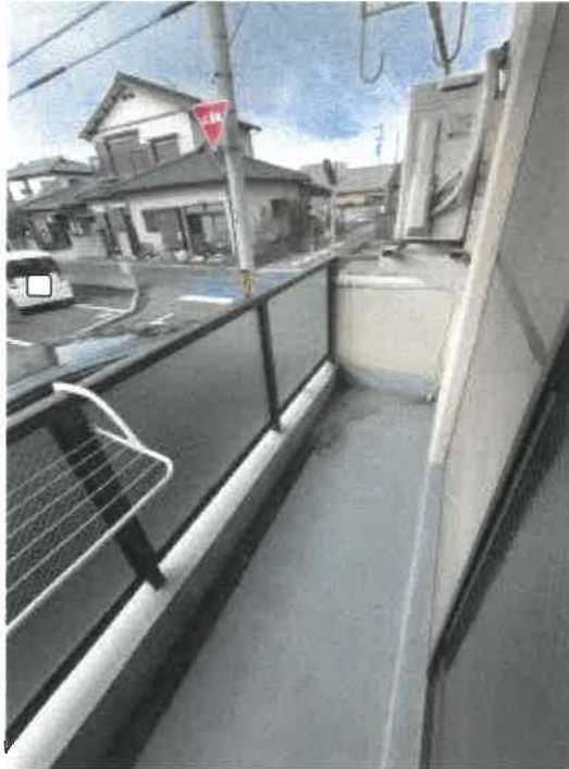
物件2 101号室バルコニーの状況
