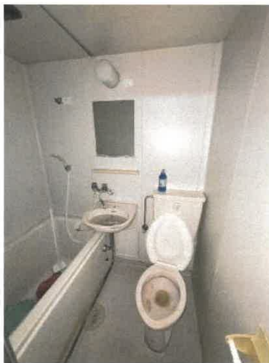
物件2 102号室ユニットバス・トイレの状況
