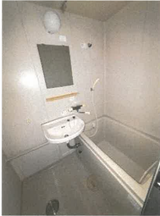
物件2 301号室ユニットバスの状況
