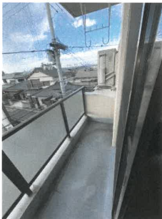
物件2 301号室バルコニーの状況
