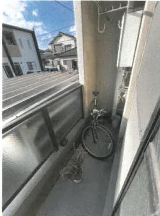
物件2 102号室バルコニーの状況
