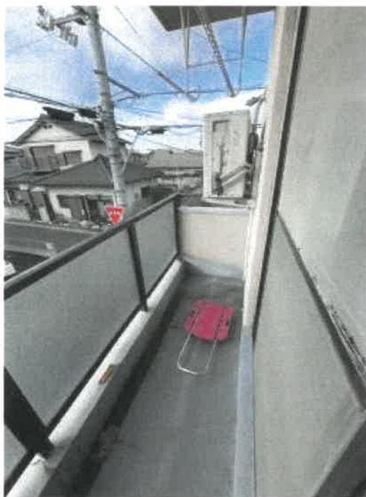
物件2 201号室バルコニーの状況
