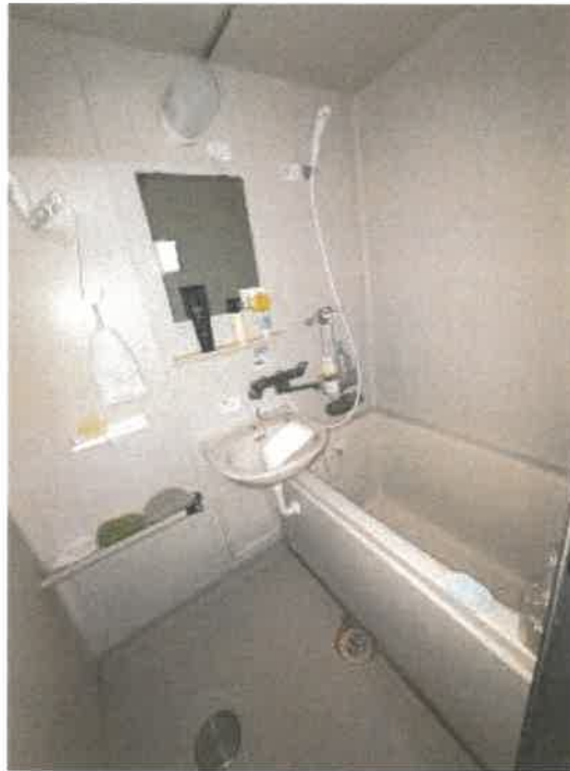
物件2 101号室ユニットバスの状況
