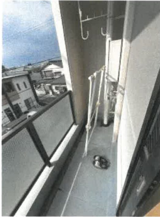
物件2 302号室バルコニーの状況
