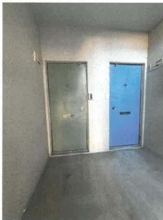
物件2 1階玄関ドアの状況
