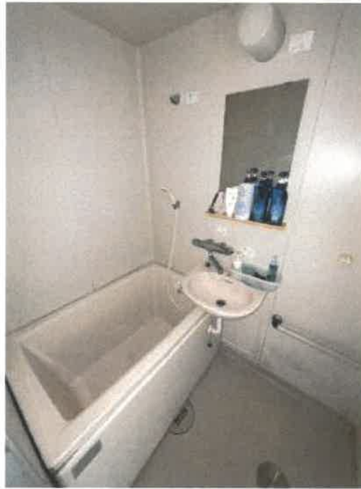
物件2 302号室ユニットバスの状況
