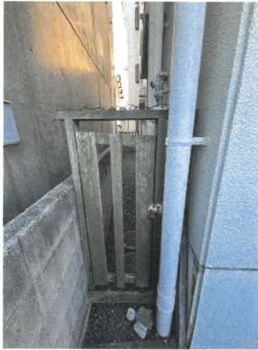
本件物件北東側の状況
