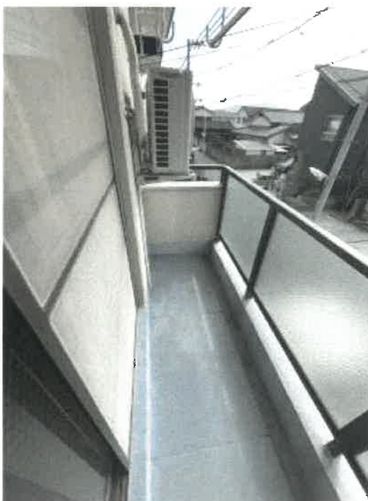
物件2 202号室バルコニーの状況
