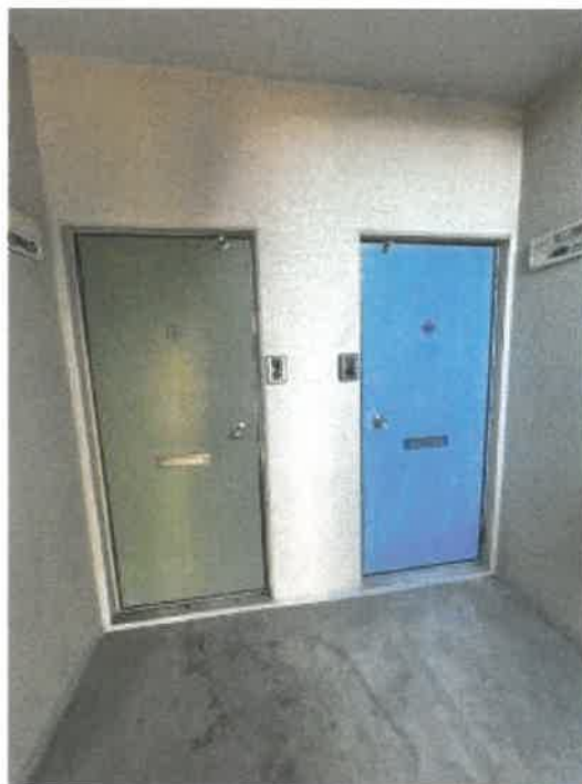
物件2 2階玄関ドアの状況
