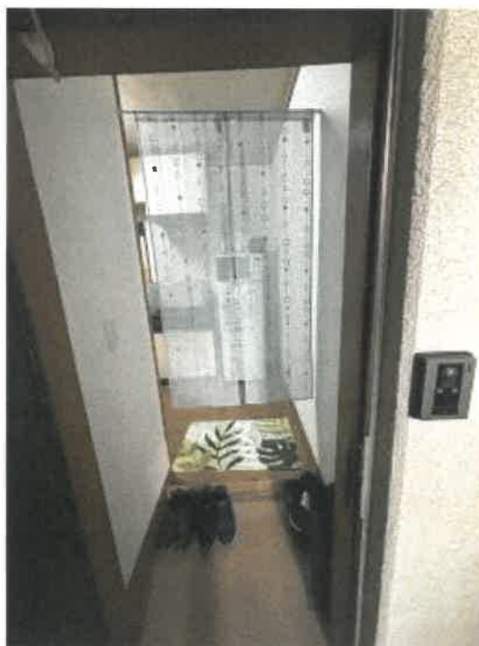
物件2 101号室玄関内の状況
