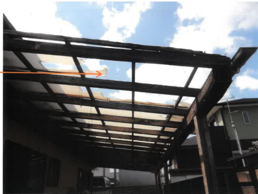
破損した下屋の 屋根
