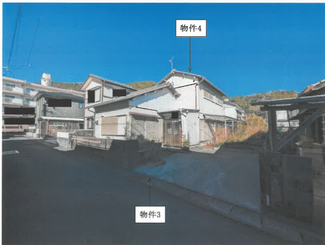
現況写真 南西方から撮影
