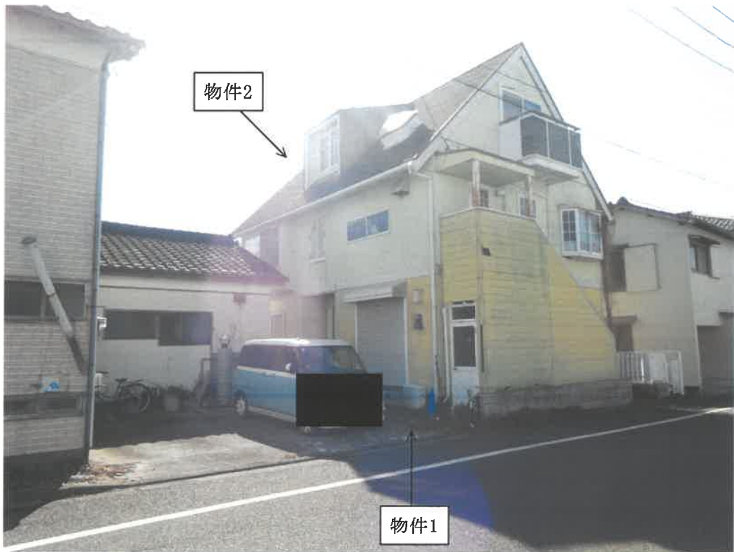
現況写真 北西方から撮影
