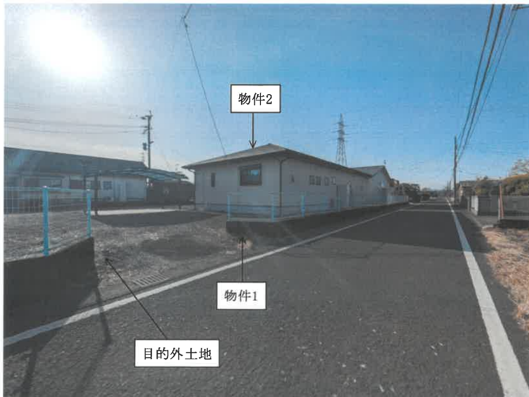
現況写真 東方から撮影
