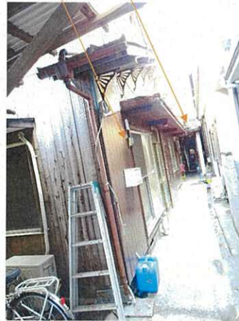
④ 物件3 主たる建物 家屋番号223番の建物
