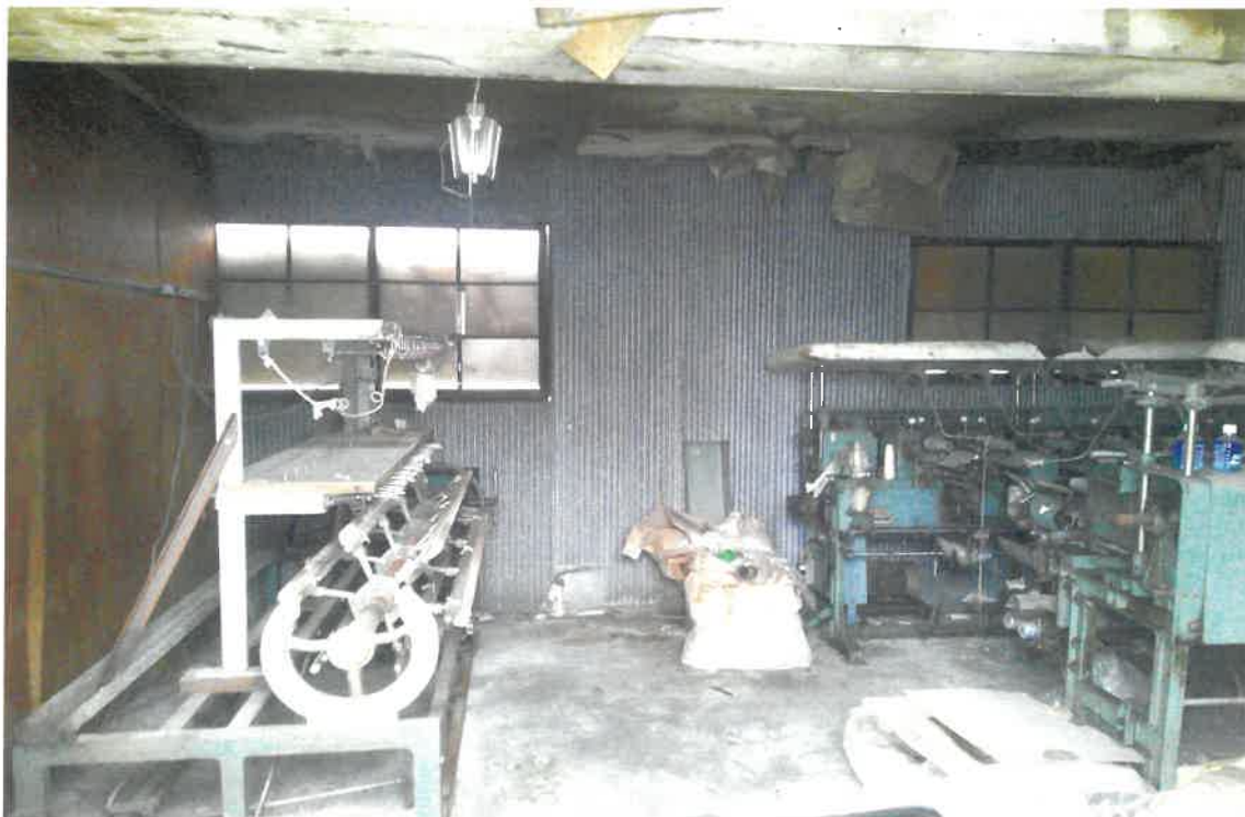
写真⑤ (物件 3 中央部分内部)
