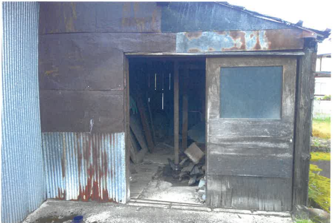
写真④(物件3 北側入口付近 )
