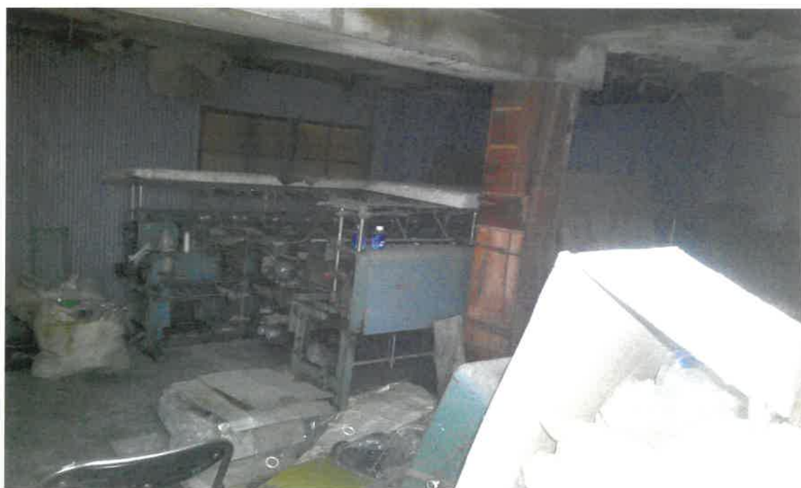
写真⑥ (物件 3 中央部分内部)
