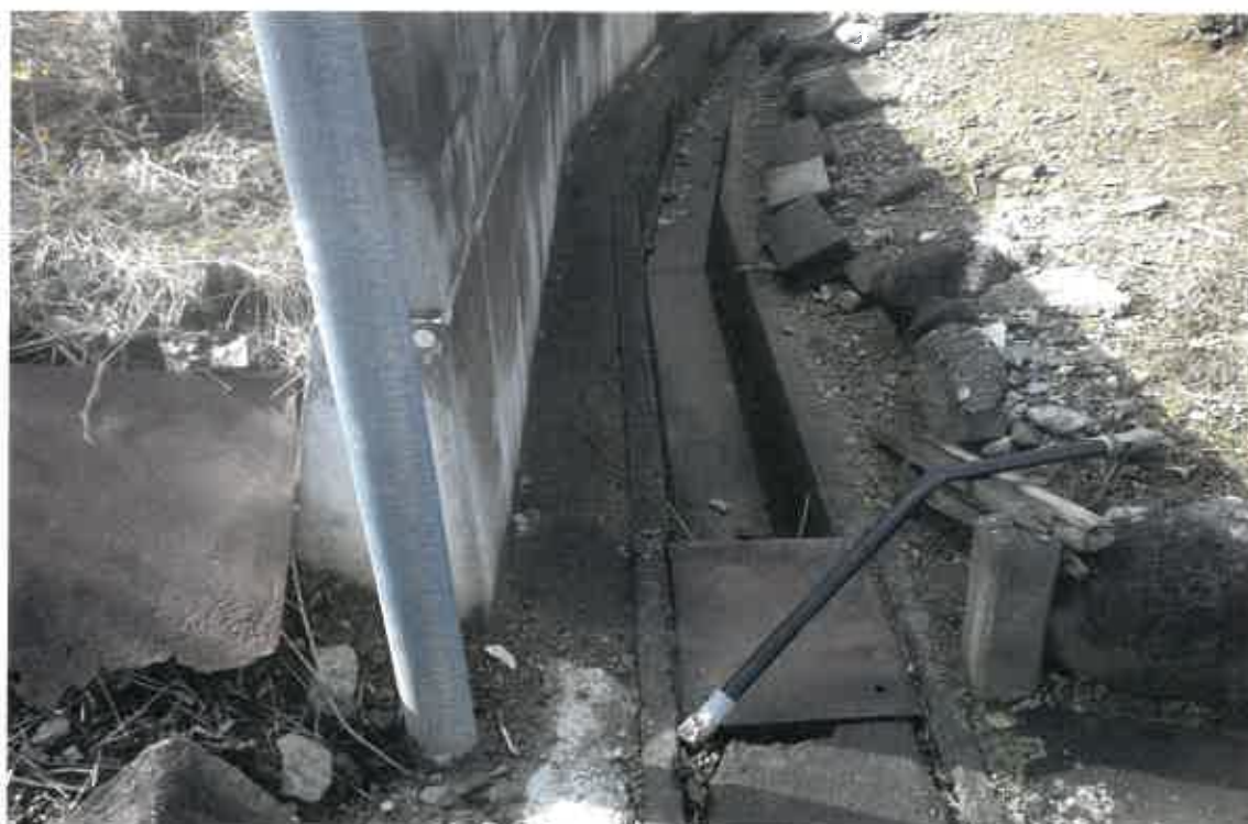
写真⑧(水路と公道接面付近)
