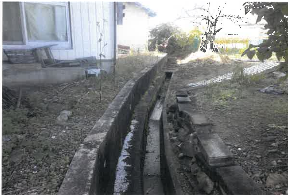
写真⑦(一体地東側水路付近)
