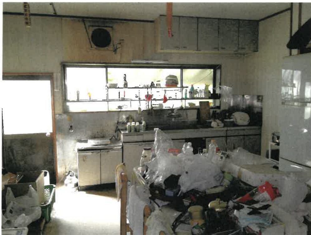
写真⑦(物件2 1階 キッチン)
