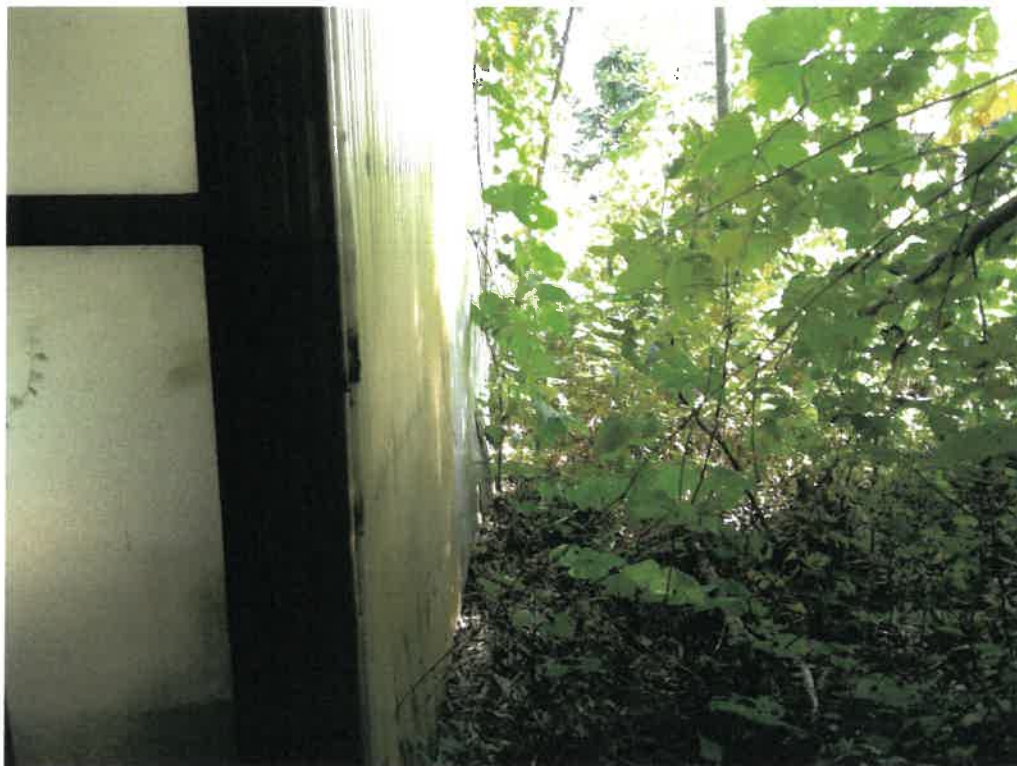
写真④(物件1 南西側境界付近)
