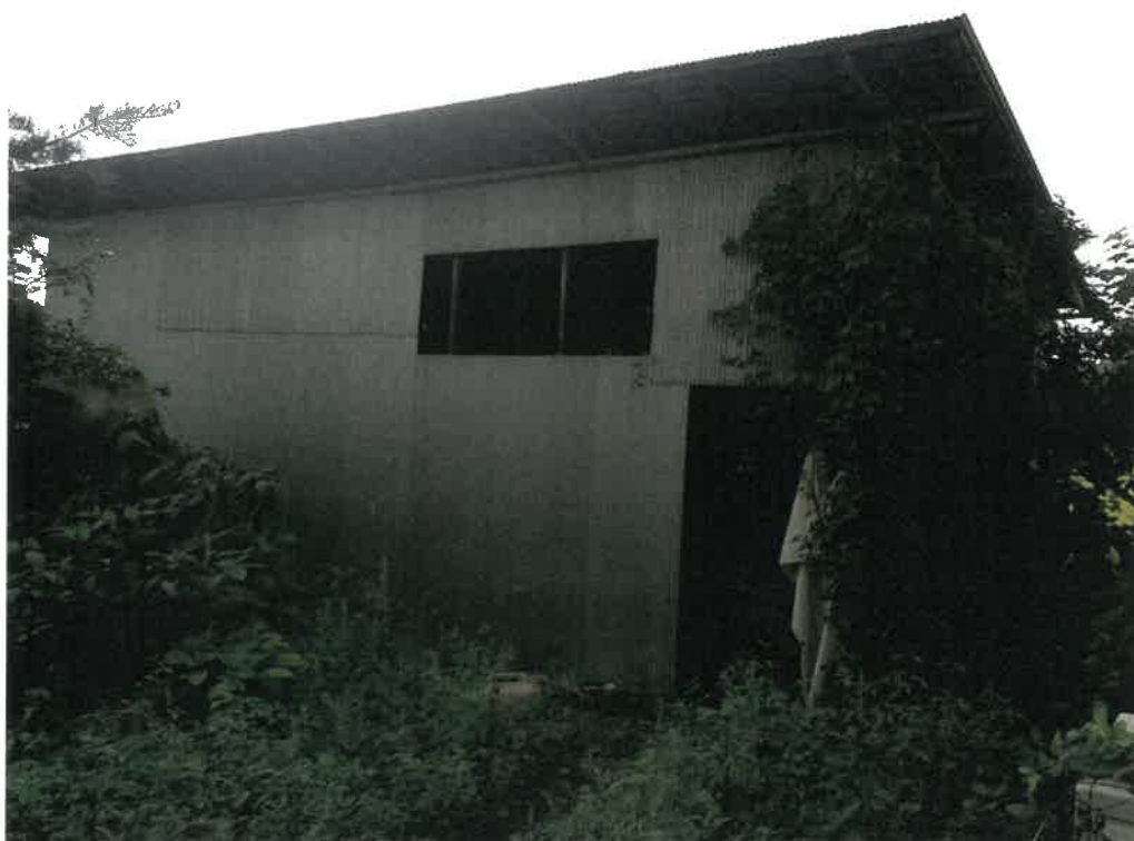
写真④(仮設物置)
