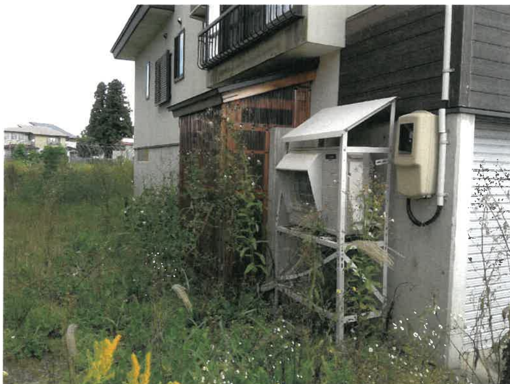
写真②(物件2 増築部分(物置))
