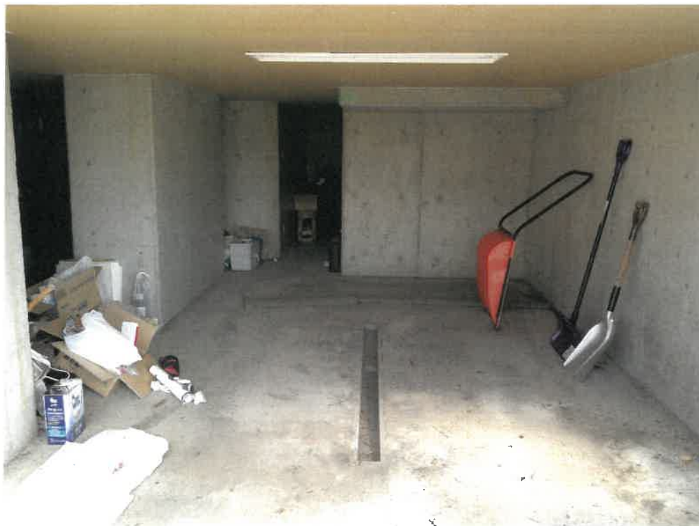
写真⑦(物件2 1階 車庫)
