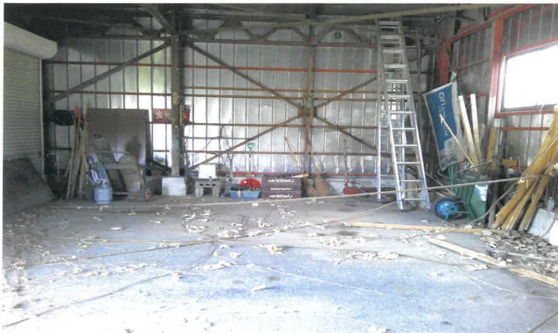
写真③(物件 9 建物内部)
