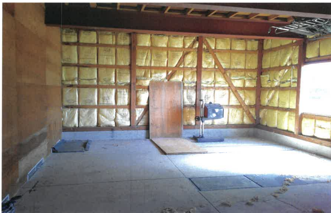
写真②(物件 8 1階 倉庫)
