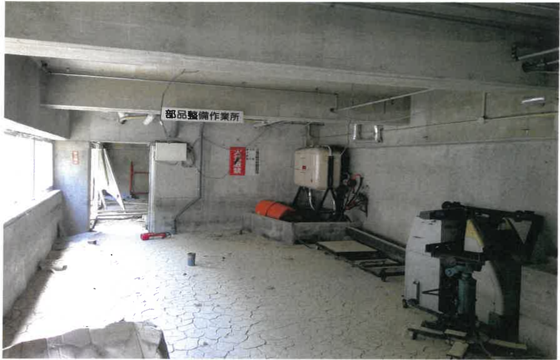
写真⑨(物件7 地下1階倉庫)
