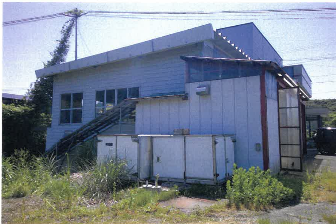
写真②(物件7 建物東側付近)
