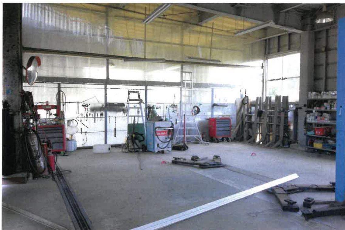
写真⑥(物件7 作業場)
