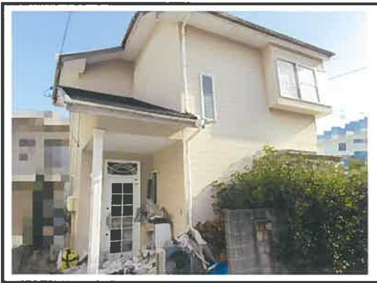
⑤ 物件2 主である建物 近景
