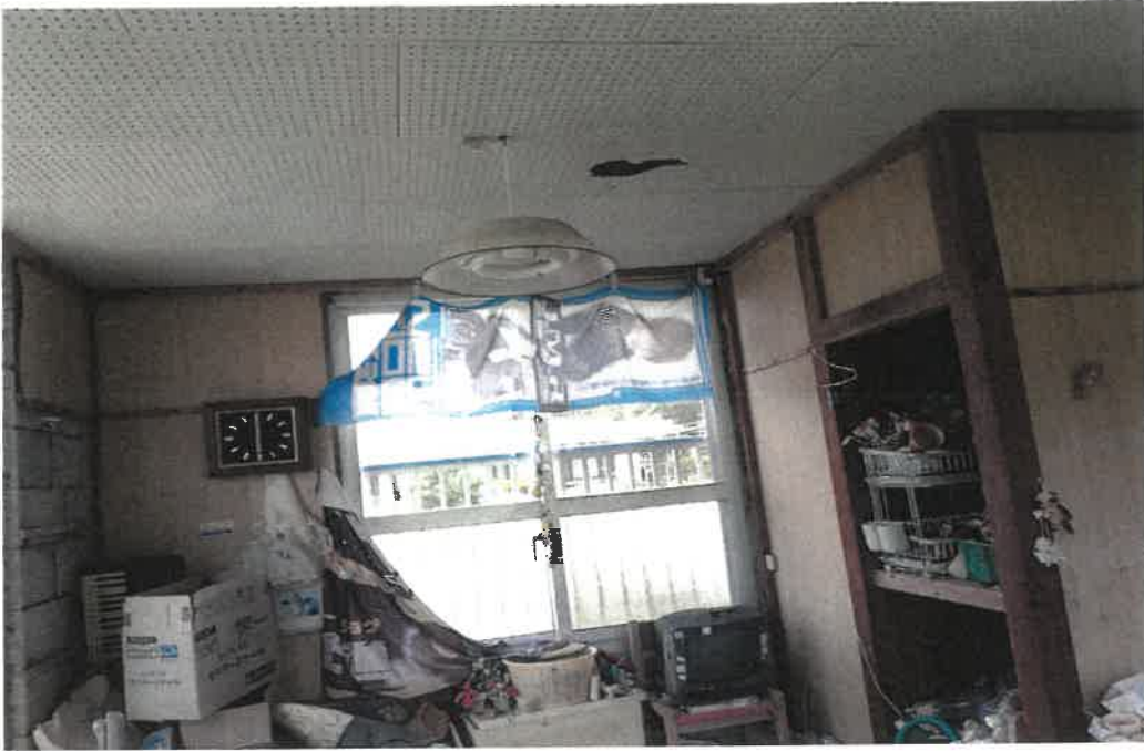
附属建物内部
