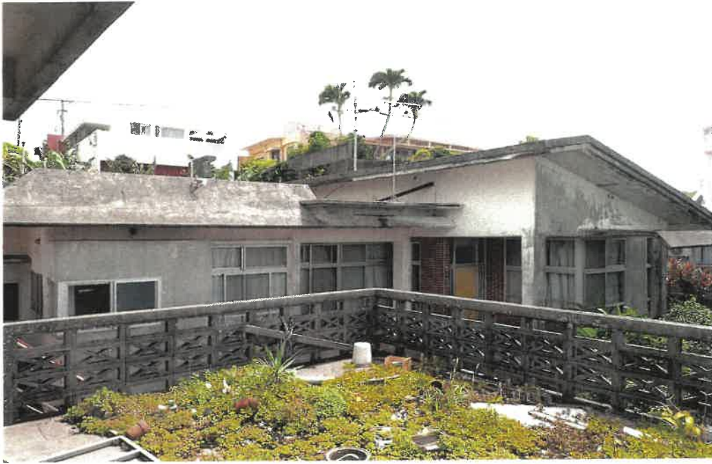
本件建物全景
