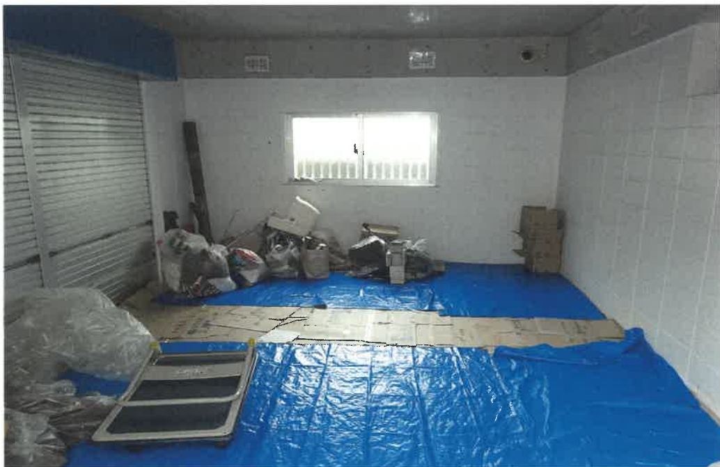
物件3の室内(附属建物)
