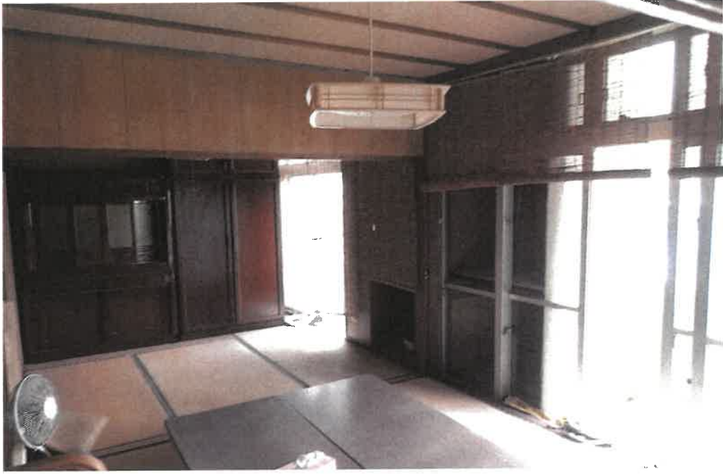
本件建物内部(3階部分)
