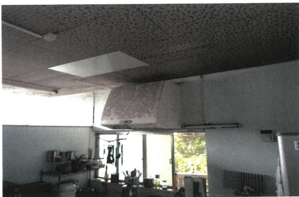
本件建物内部(1階部分)
