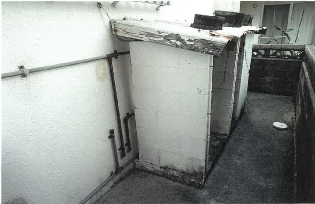
ボイラー室(附属工作物)
