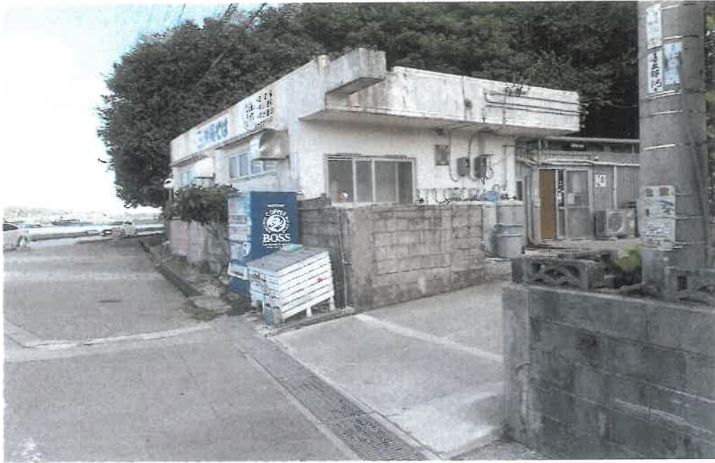
本件建物全景
