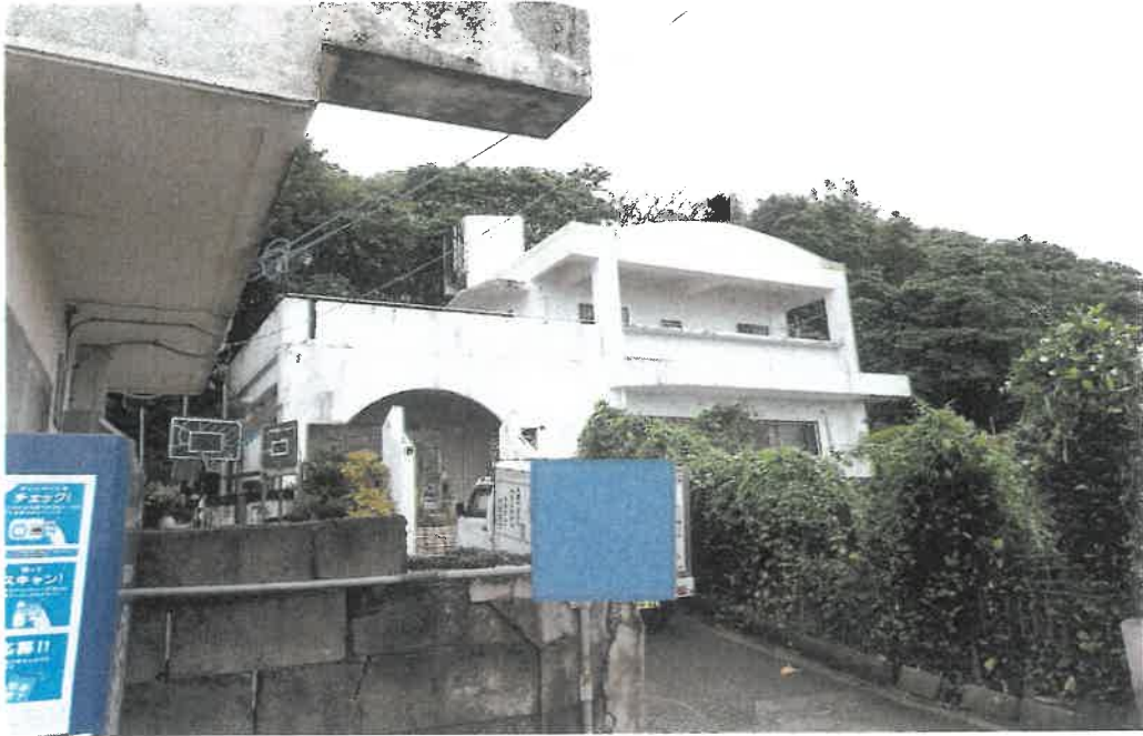
本件建物全景
