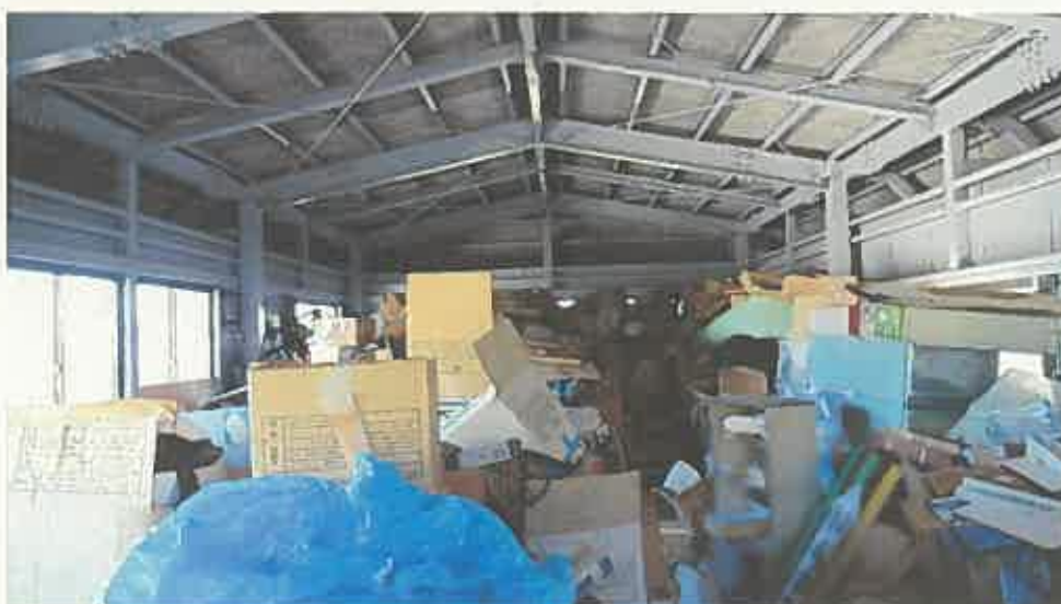
物件 5 建物内部の状況 (3 階)
