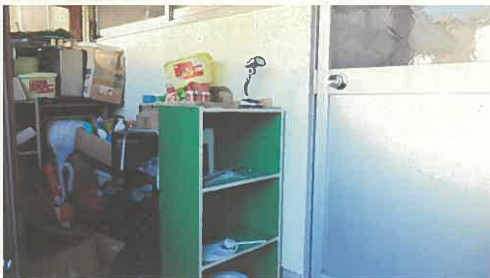
下屋内部の状況
