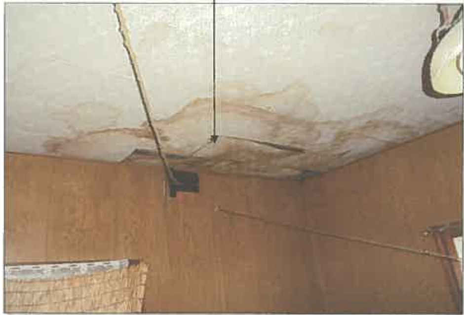
雨漏りによる天井の腐食
