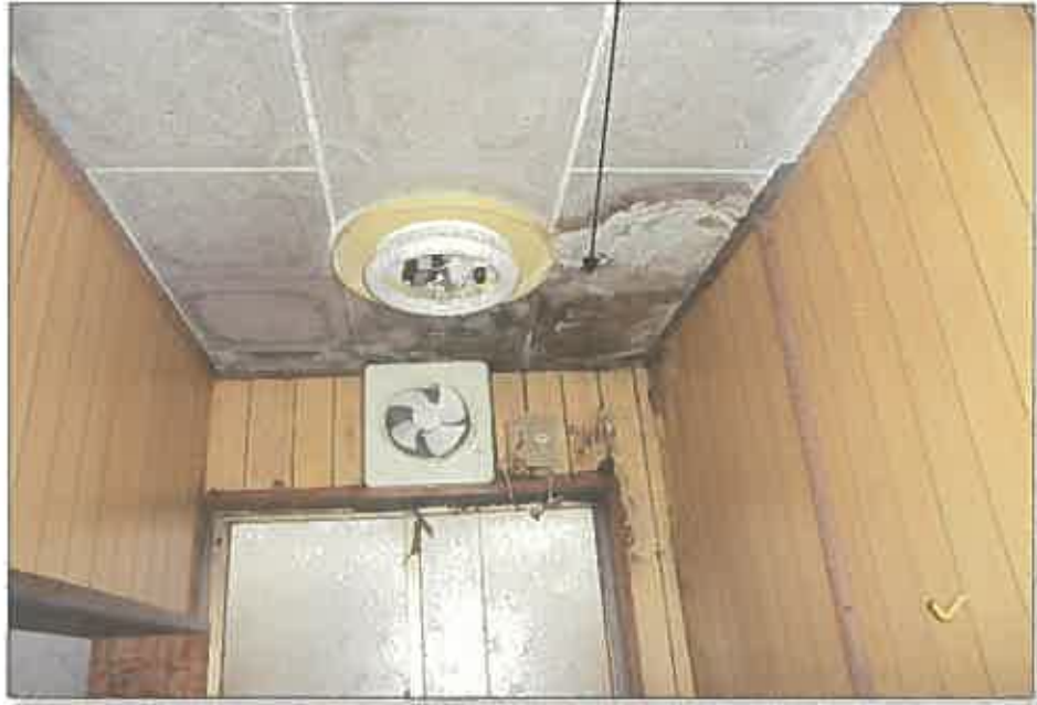
雨漏りによる天井の腐食
