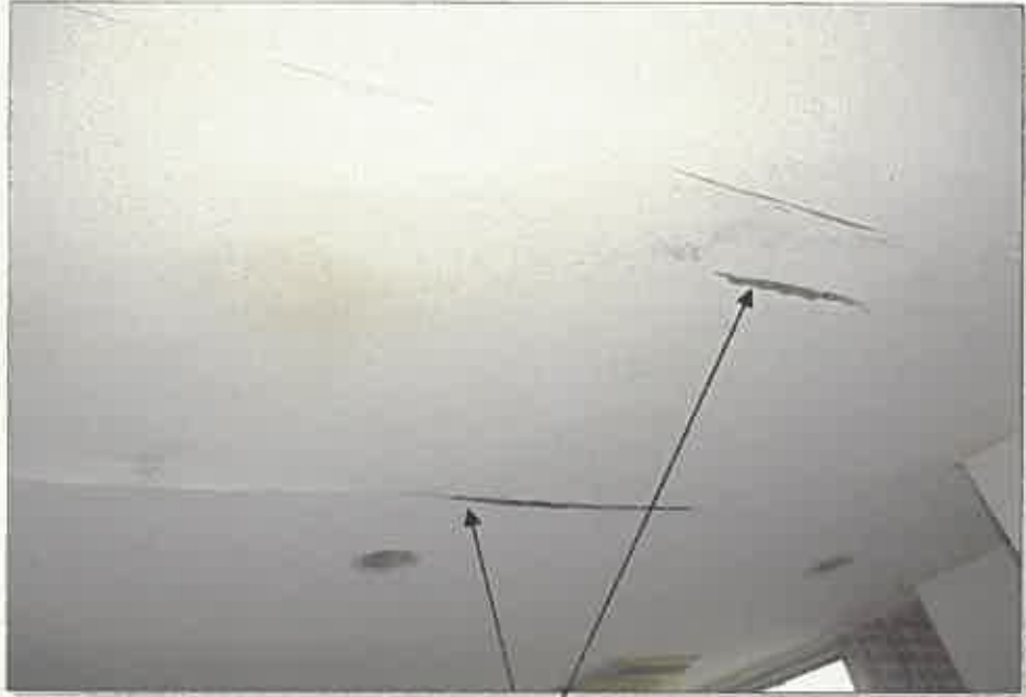
天井クロスの損傷
