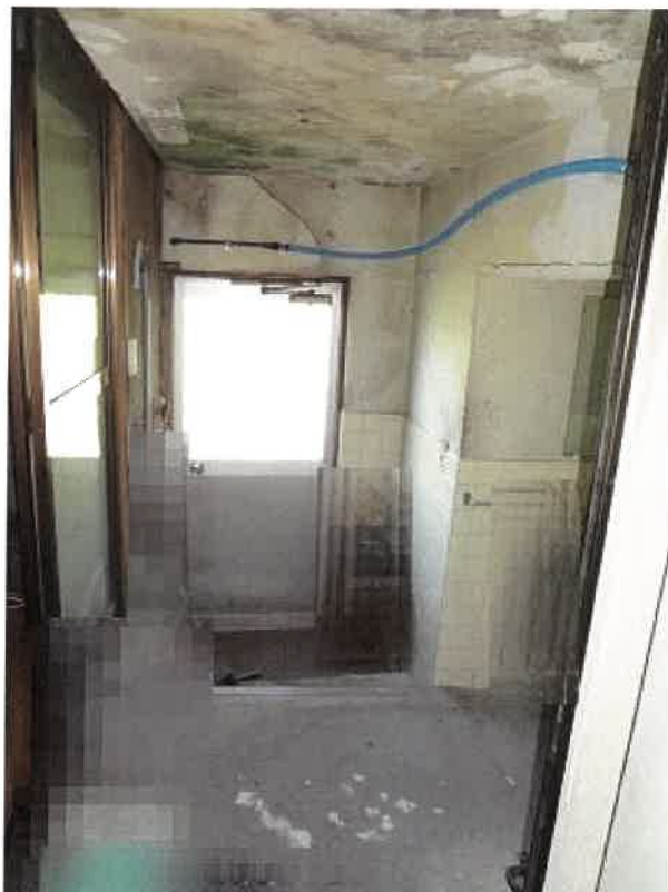
1階通路（未登記増築部分）
