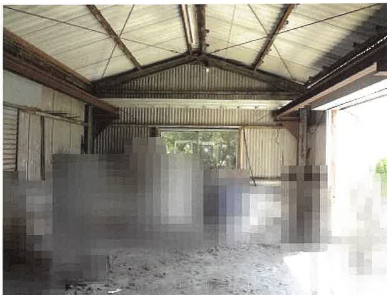
物件4 附属建物符号3内 (倉庫)
