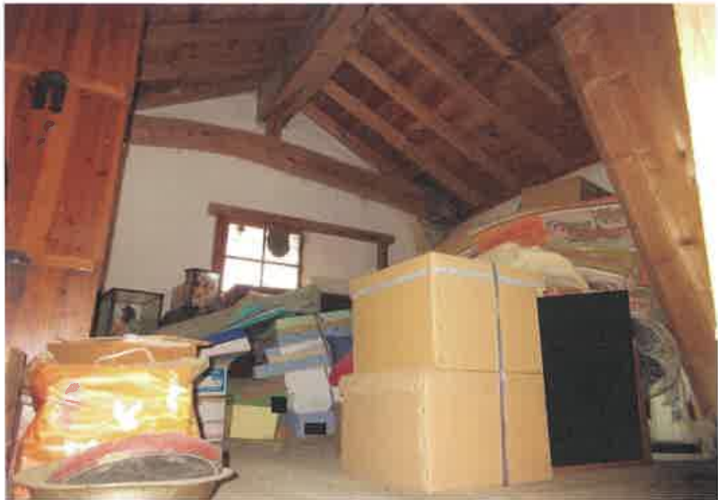
物件5附属建物符号1:2階内部の状況
