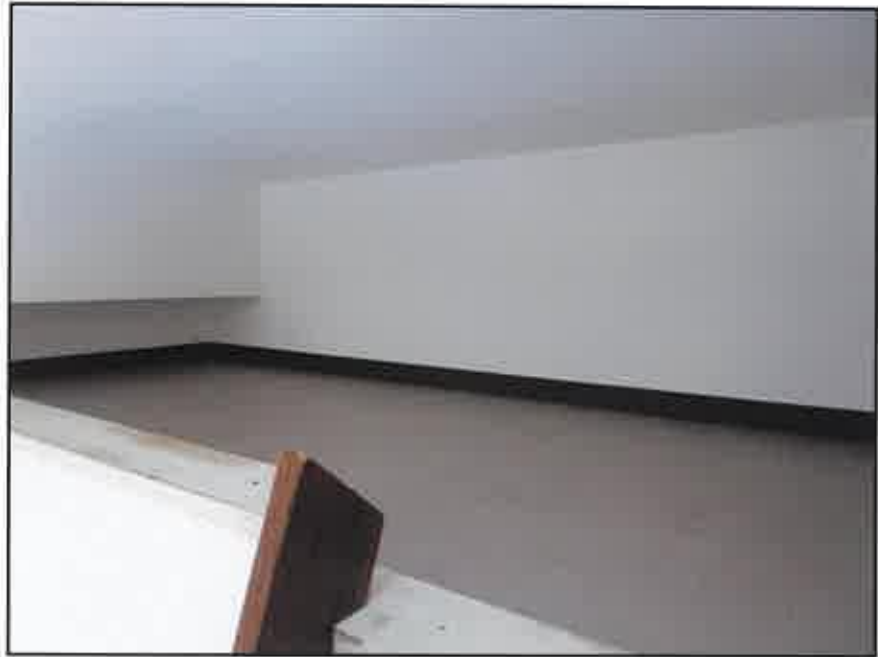
⑬ 建物内の状況—202号室:ロフト
