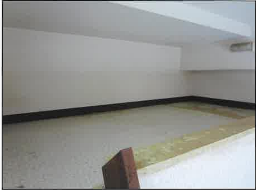
⑤ 建物内の状況－105号室:ロフト
